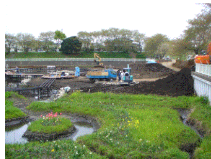
ビオトープ工事中のこてはし台調整池
