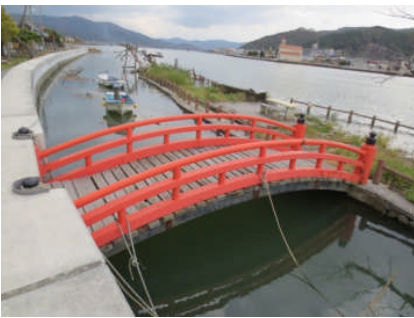
旧北上川沿いの地盤沈下(芭蕉も訪れた歌枕「袖の渡り」。地盤沈下と仮堤防の設置で、島には渡れない)
