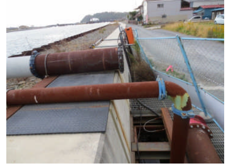
仮設排水ポンプ(河岸を埋立てて高さ7mの堤防が整備される。下流の白いドームは石の森萬画館)
