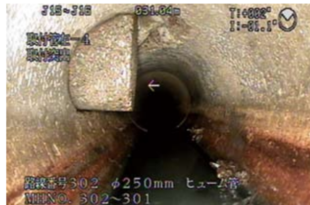
▲ 下水道施設が原因で起こった道路陥没と、下水道本管に突出した取付管 (2013年1月30日、3月27日連続研究集会「排水設備と取付管の今日的役割」講演資料より)
