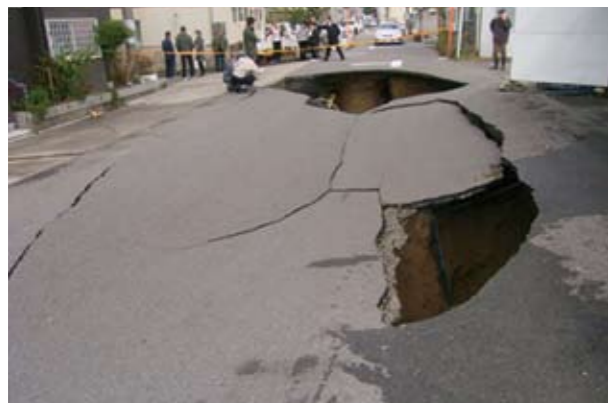
▲ 下水道施設が原因で起こった道路陥没と、下水道本管に突出した取付管 (2013年1月30日、3月27日連続研究集会「排水設備と取付管の今日的役割」講演資料より)
